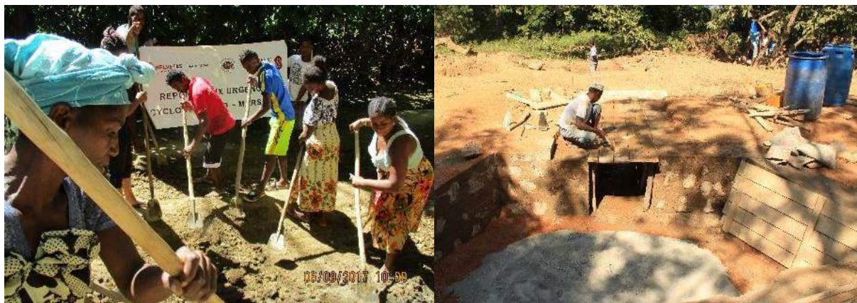
Figure 51: Réhabilitation des dégâts de la route vers le Haut Sambirano
